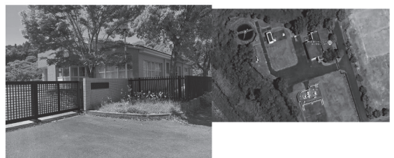
臼杵市野津浄化センター
