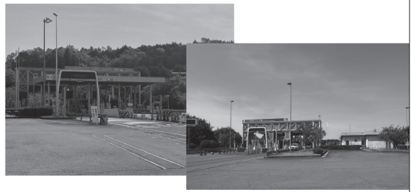
大分農業文化公園インターチェンジ
