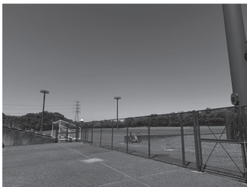
大分県スポーツ公園 サッカーラグビー場Aコート 照明塔
